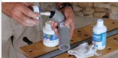
Poncer et nettoyer les zones de contact avec du décapant PVC puis appliquer la colle PVC.
