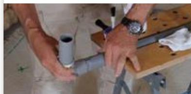
Emboîter les éléments du montage en veillant à bien respecter l'alignement des repères tracés à l'étape 2. Essuyer le surplus de colle et laisser sécher le montage.
